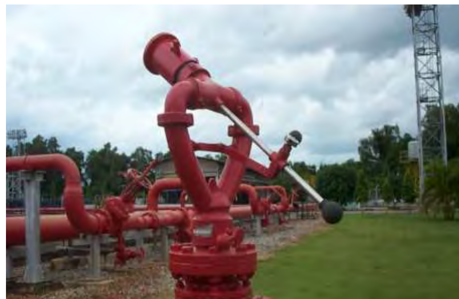
▲ ร้วฉีดน้ำดับเพลิงแบบประจำที่ (Fixed Water Monitor) อัตราการฉีด 1,900 ลิตร/นาที จำนวน 8 จุด
